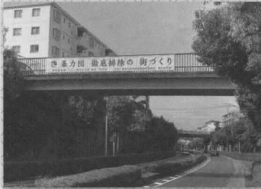
きょうづか歩道橋 取付後
