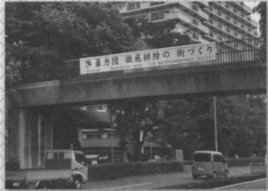
新田歩道橋 取付後
