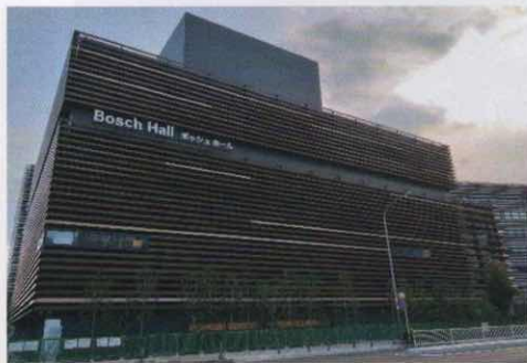
区民文化センター 外観
