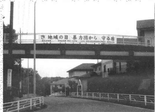
川和歩道橋 取付後
