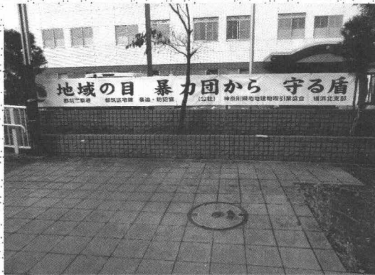
都筑警察署フェンス 取付後
