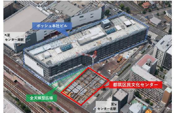
建設現場全景(空撮) 2023年6月18日
