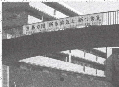
さわかせ歩道橋
