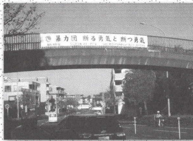
華蔵橋歩道橋
